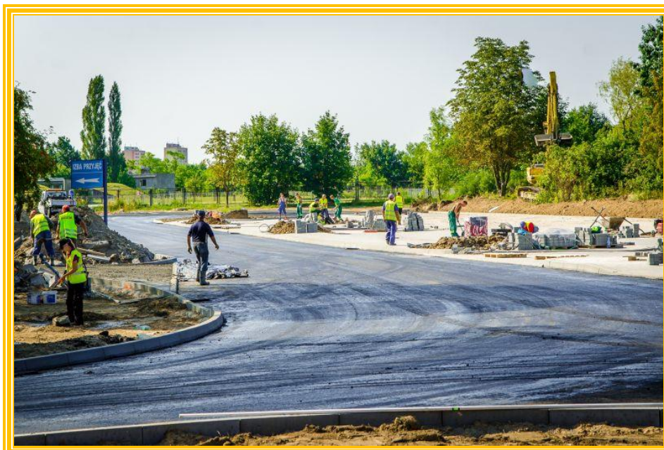
Remont ul. Dekerta w Gorzowie Wlkp., fot. Urząd Miasta Gorzowa Wlkp.
